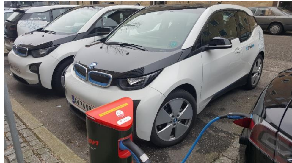
von ENIO für E.ON gesteuerte Ladestelle in Dänemark
